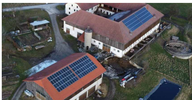
Die Photovoltaikanlagen vom Biohof Schmitsberger in Oberösterreich.
